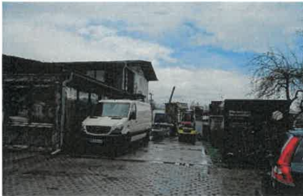
Abb. 3: Ostseite der bestehenden Lagerhalle; hier ist eine neue Halle geplant.
