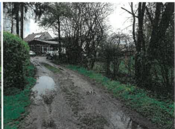
Abb. 6: Dto., hier rechts, Blick in die Gegenrichtung.
